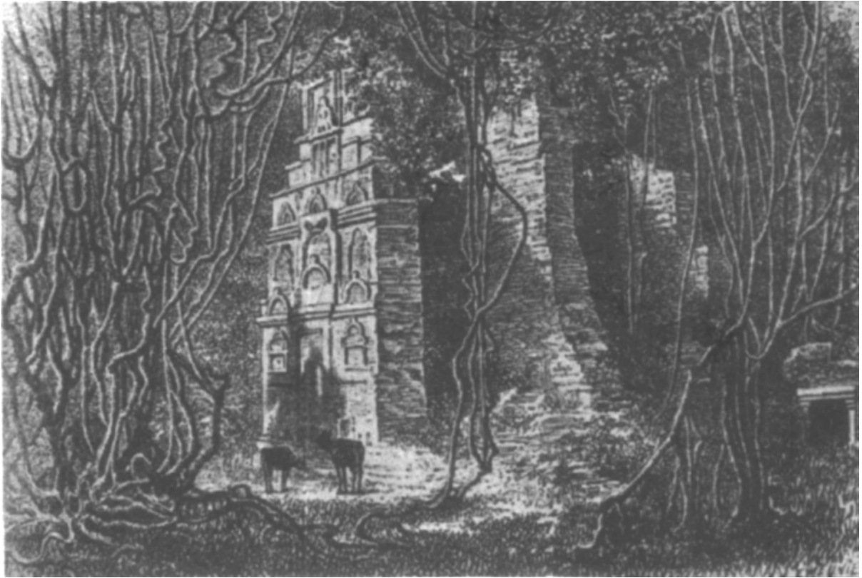
4. — Les ruines du temple de Bachong, à Stung-treng (dessin de L. DELAPORTE dans le t. 1 de la Mission d'exploration). Édifices de briques de style vieux-khmer (« pré-angkorien »). C'est là « l'église » où se rendaient les piroguiers laotiens de WUYSTHOFF.
