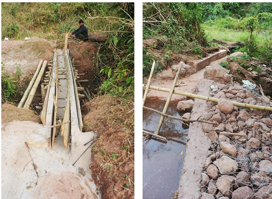
*Figure 5 : A gauche, construction d'un canal pour amener l'eau à la rizière. A droite, construction d'un bassin de rétention d'eau. Village de Ban Nakong, district de Gnot Ou*
